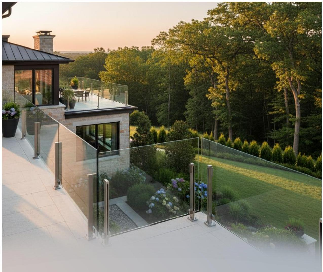
Il sistema di Parapetto composto da profili in lega di alluminio appartenente alla serie OVER sistema con montante 60% in lega di alluminio 6063 costituito da profili di sezione 50x30 mm.
