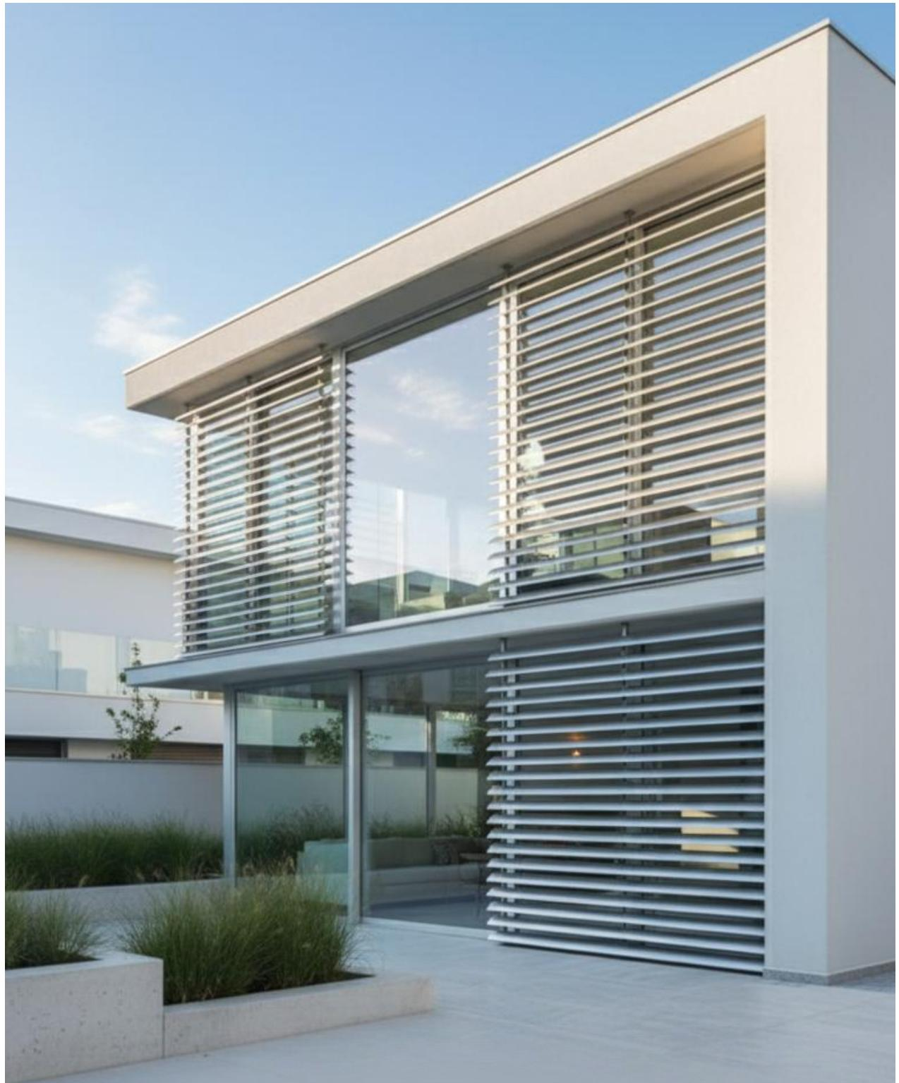
Il sistema frangisole LID è composto da profili ellittici in alluminio da 120 x 26 mm. Questa geometria è fondamentale perché massimizza l'ombreggiamento in base all'angolo solare e contemporaneamente riduce la resistenza al vento.
